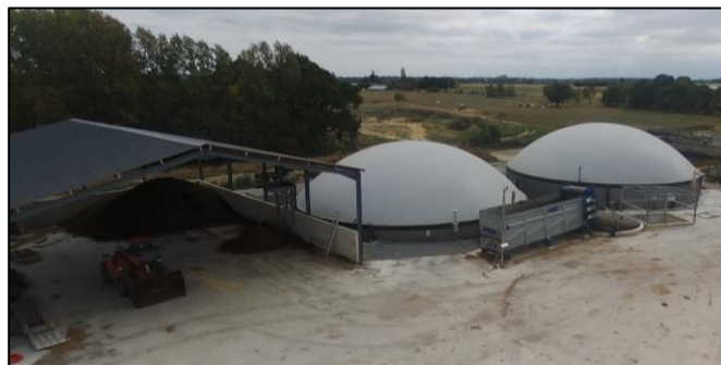
Figure 10 : Photographie du digesteur et du post-digesteur de la SAS NATURE ENERGIE
