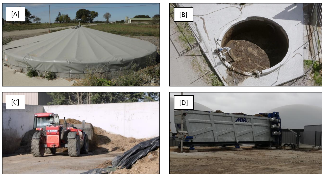
Figure 9 : Photographies de la zone d'incorporation de la SAS NATURE ENERGIE
