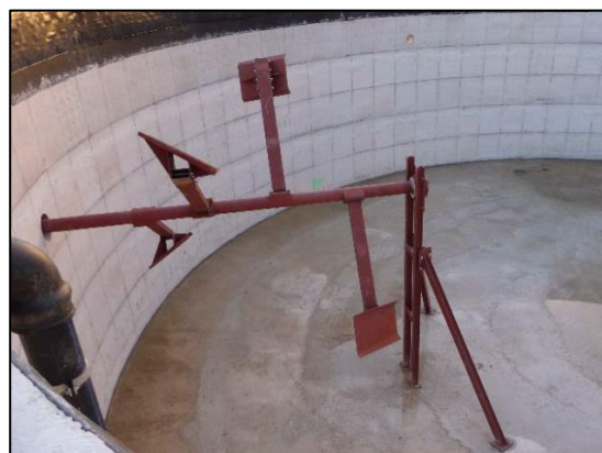
Figure 12 : Exemple d'agitateur lent
