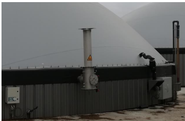
Figure 43 : Photographie de la signalisation de la zone ATEX sur la soupape de sécurité du post-digesteur de la SA NATURE ENERGIE.
